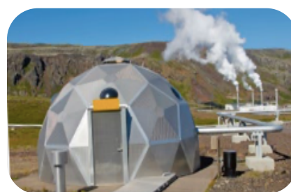
Imagen 6. Fuente de energía geotérmica.
